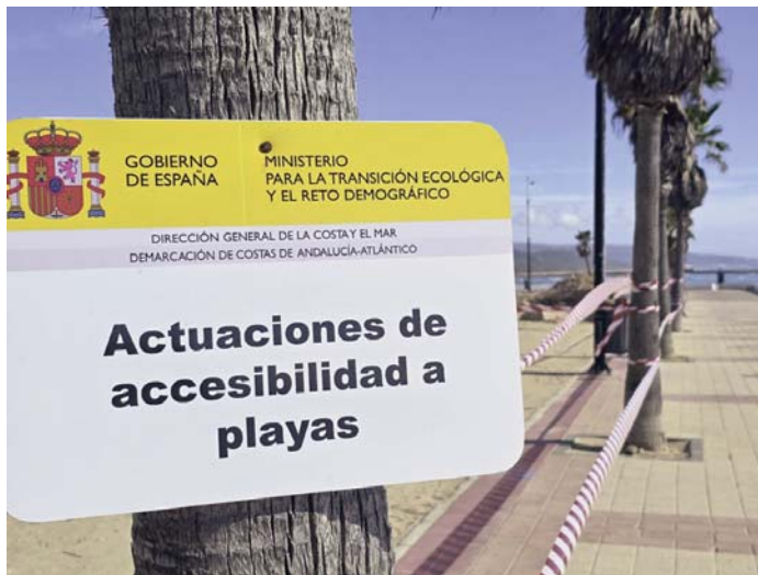
Cartel informativo de las obras que se están ejecutando en la zona del final del Paseo Marítimo de Barbate.
